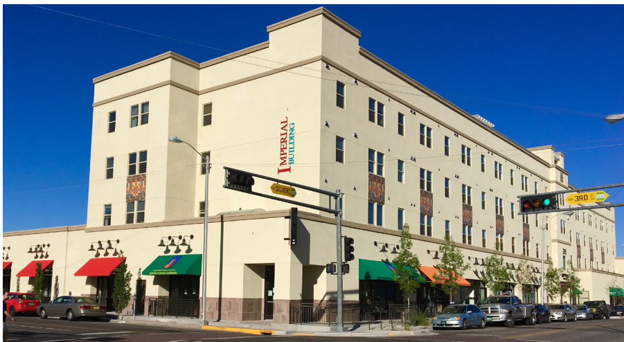
Imperial Building. 68 unidades de vivienda asequibles, desarrolladas junto con una tienda de comestibles de 6,000 pies cuadrados para dar solución al desierto alimentario que aqueja al centro de Albuquerque (2016).
