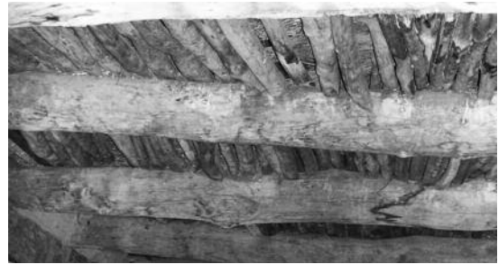
Vigas and latillas at Casa San Ysidro.
