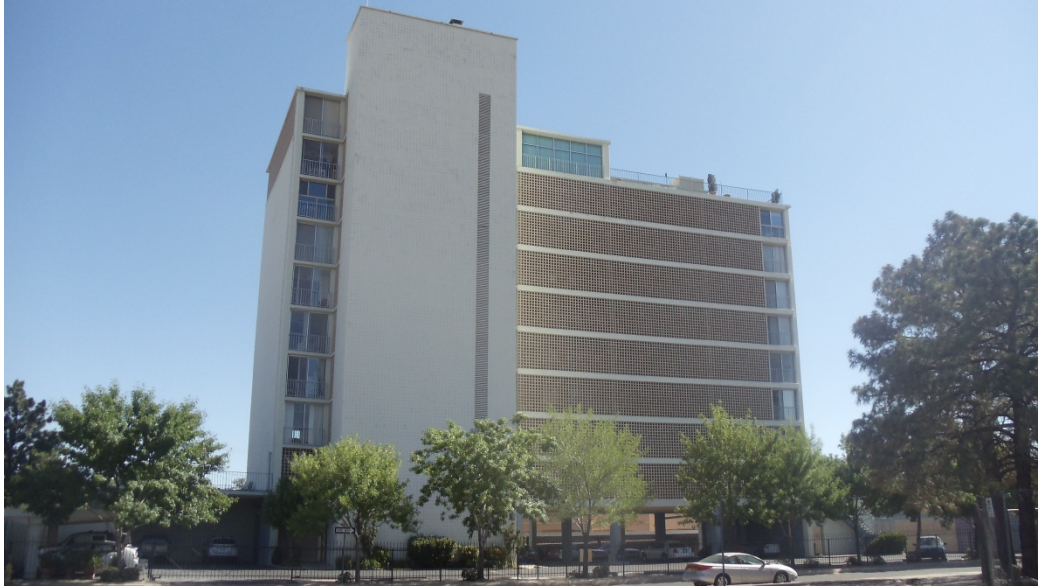
Alcalde Place Apartments, 600 Alcalde Pl. SW (1963)
