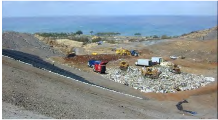
Biogas (Landfill) Facility
